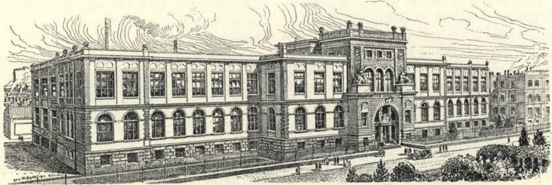
• Das Hauptverwaltungsgebäude (Hauptbüro) der „Höchst Farbwerke“.
