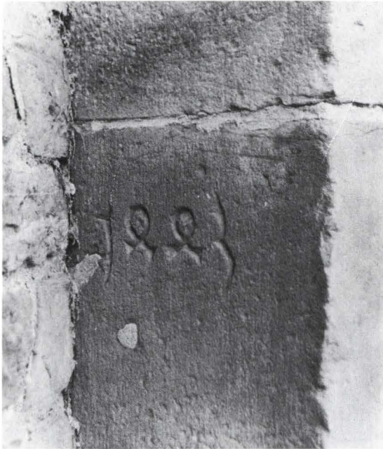
Abb. 43: Baudatum 1443 am Nordoststrebepeer des Chores
