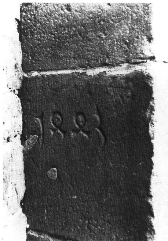
Baudatum 1443 am nordöstlichen Chorstrebepeiler.
