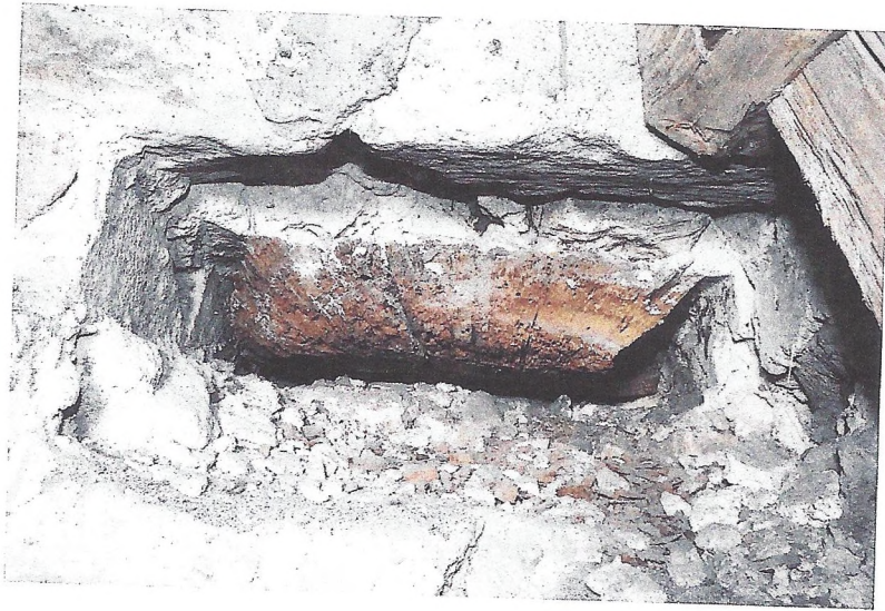
Abb. 3 Die dendrochronologisch datierte Mauerlatte. Links ist im Mörtel der Abdruck des geschwun- denen Balkens eindeutig zu erkennen. Katarina Papajanni, 2014
