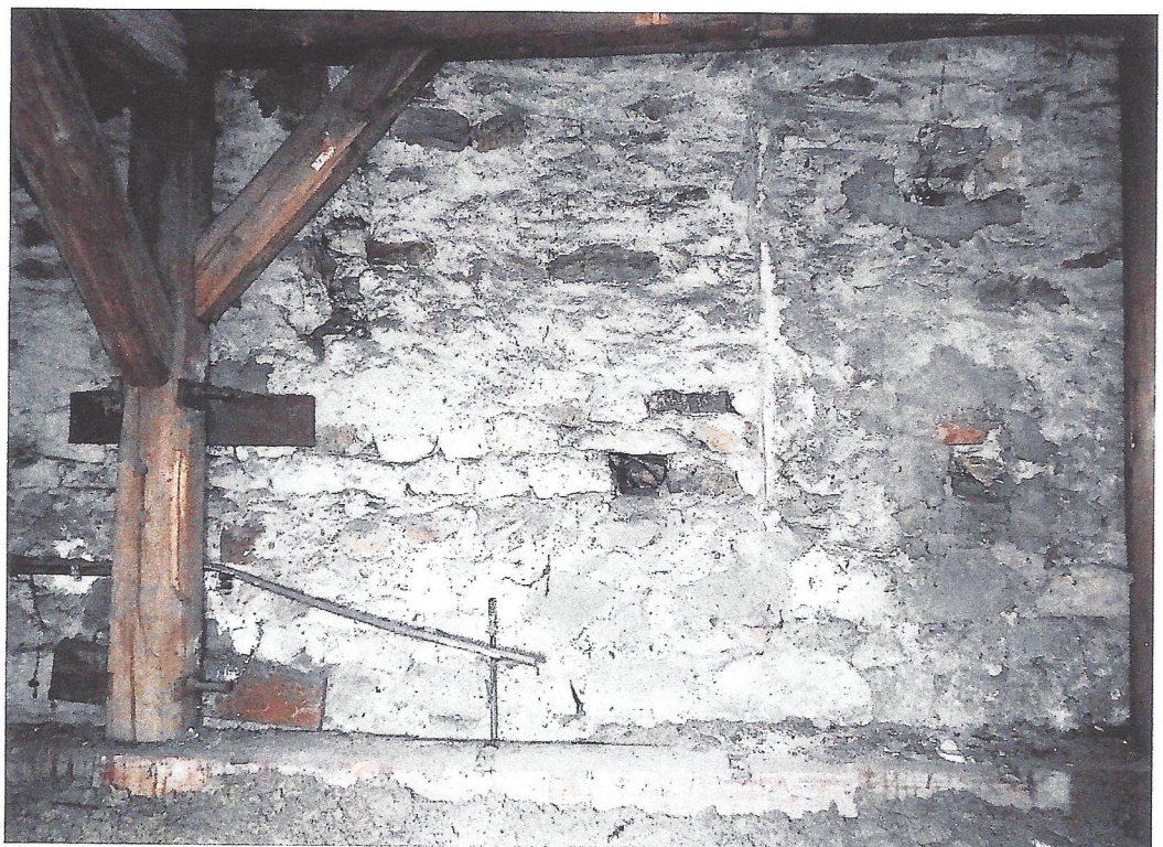
Abb. 12 Nordseitenschiffdach, Bruchsteinmauerwerk mit pietra rasa . Katarina Papajanni, 2016
