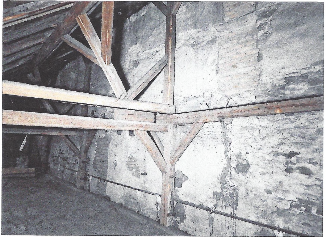
Abb. 11 Nordseitenschiffdach, Blick von Nordwesten auf die Außenwand des Obergadens. Katarina Papajanni, 2016
