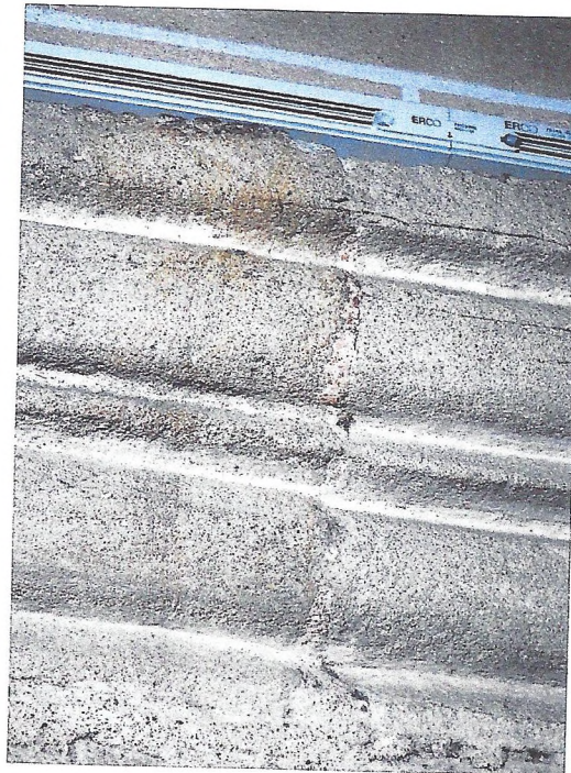
Abb. 7b Mittelschiff, Nordseite, Gesims über der westli- chen Nordarkade. Ziegel- splithaltiger Fugenmörtel. Katarina Papajanni, 2016
