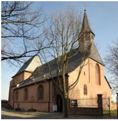
Kirchhof und Nordfassade der Justinuskirche
