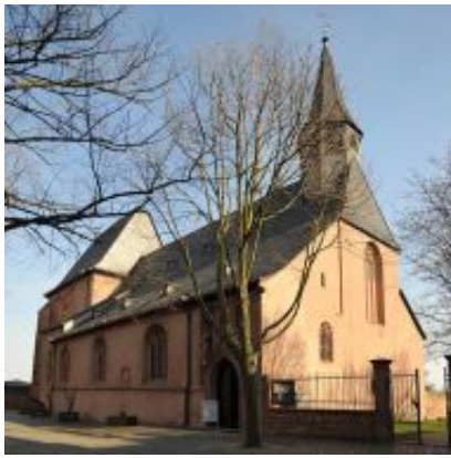
Kirchhof und Nordfassade der Justinuskirche
