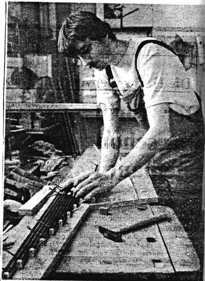
Bild rechts Lukas Seiser beim Montieren der Verbindungsstäbe zwischen Tastatur und Pfeifen — bis die Justinusorgel (Bild Mitte) endgültig ihrer musikalischen Bestimmung übergeben werden kann. (Bilder: Hoechst AG)
