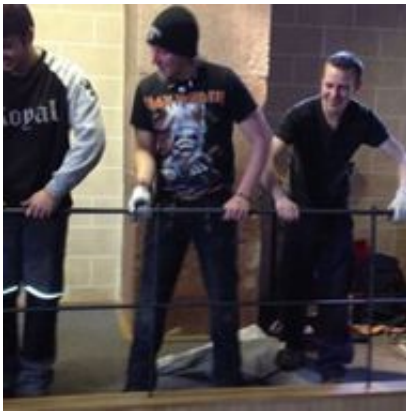
Neues Geländer an der Rollstuhlauffahrt
