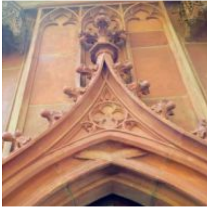
Restaurierte Sandsteinteile an Hauptportal
