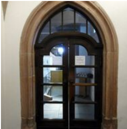
Gereinigter Sandstein an der Schwingtür
