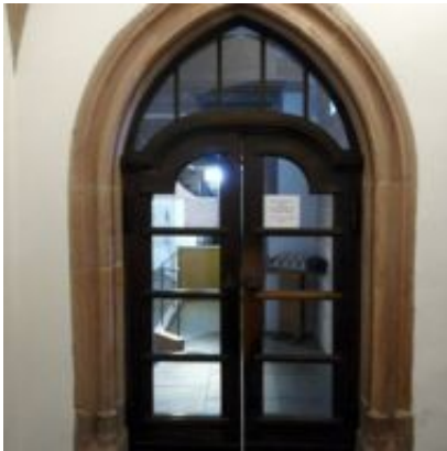
Gereinigter Sandstein an der Schwingtür
