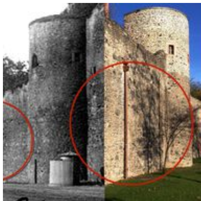
Die neue Wasserableitung (rechts) und die so sanierte alte (links)
